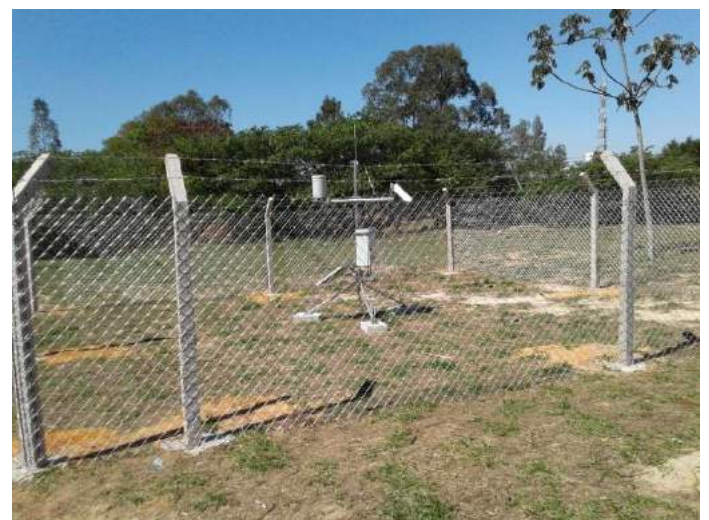
Cercado construído pela Defesa Civil / Prefeitura de Americana
